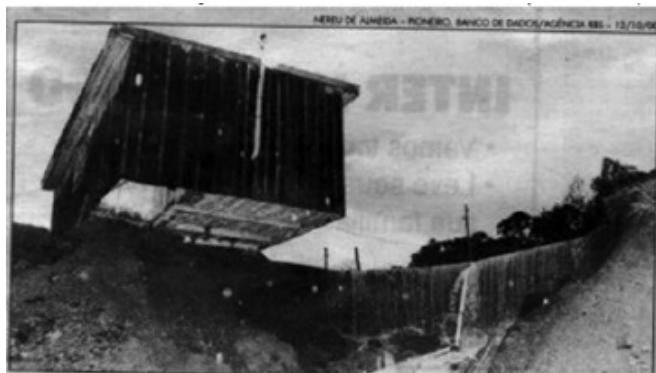
FIGURA 69 – OCUPAÇÃO URBANA DE ÁREAS DE RISCO (ENCOSTAS)
